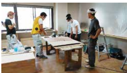
建設インターンシップの様子
