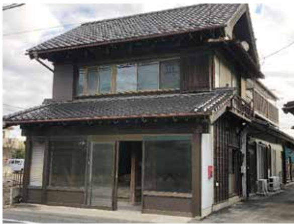
シェアハウスに改修した製麺所跡
