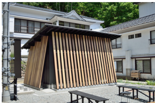
消雪施設機械格納庫 (2015年5月完成)
